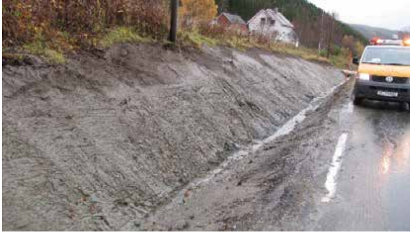
Figur B1.5 Eksempel på at eiendomsgrense ligger så nært vegen at det ikke er plass til god nok helning på skjæringsskråning, med påfølgende erosjon og gjentetting av grøfta over tid. (Foto: Per Otto Aursand, Statens vegvesen).
