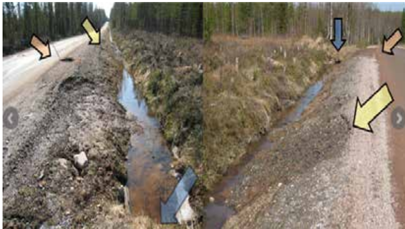
Figur A5.15 Eksempel på tett stikkrenne i avkjørsel som fører til vannrelaterte skader på vegen oppstrøms. [31]
