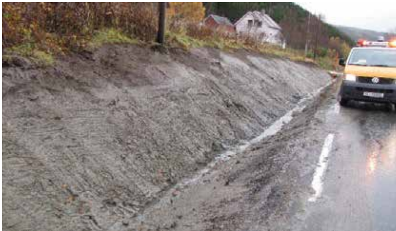
Figur A5.11 Eksempel på at eiendomsgrense ligger så nært vegen at det ikke er plass til god nok helning på skjæringsskråning, med påfølgende erosjon og gjentetting av grøft over tid. (Foto: Per Otto Aursand, Statens vegvesen)
