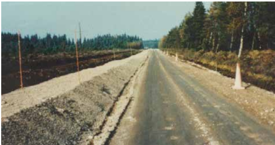
Figur A6.7 Forbelastning ved breddeutvidelse over myr. [19]
