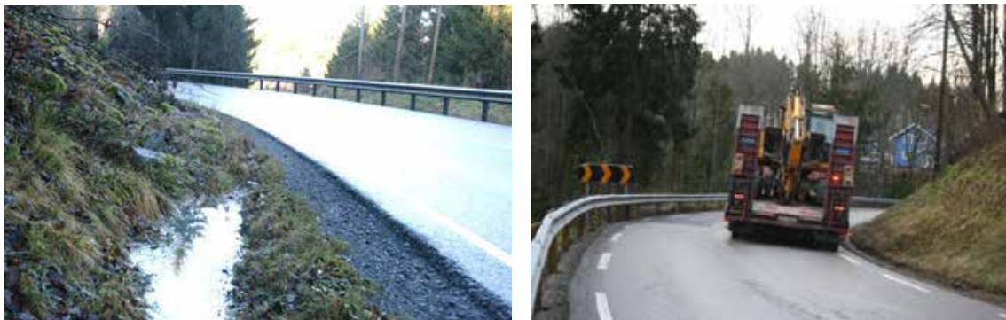
Figur A5.1 Det kan ofte være behov for punktvis utbedring av grøft og grøfteskråning (t. v.). Smal veg, manglende grøft og tunge kjøretøy gir rask nedbrytning av vegen (t. h.). [23]
