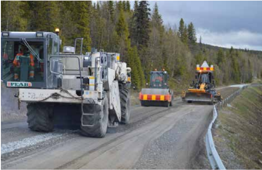
Figur B11.1 Tørrstabilisering. (Foto: Statens vegvesen)
