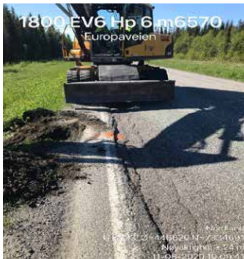
Figur A5.17 En utilsiktet fuktfelle i vegoverbygningen (Sandwich). [31]
