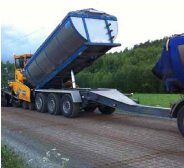
Figur B17.1 Legging av stålnett over bitumenstabilisert bærelag. (Foto: Statens vegvesen)
