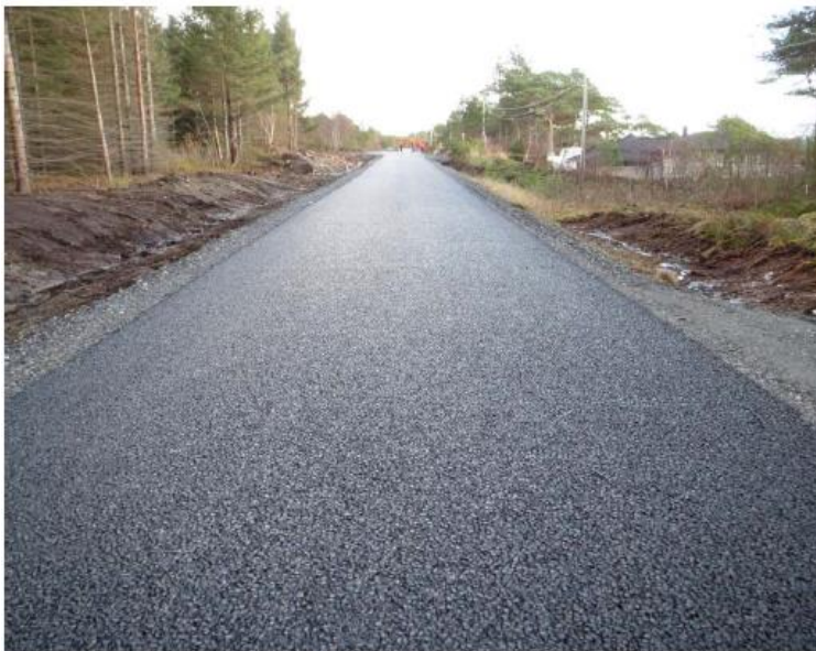
God utførelse, homogent asfaltdekke (foto: Jan Sundstrøm)
