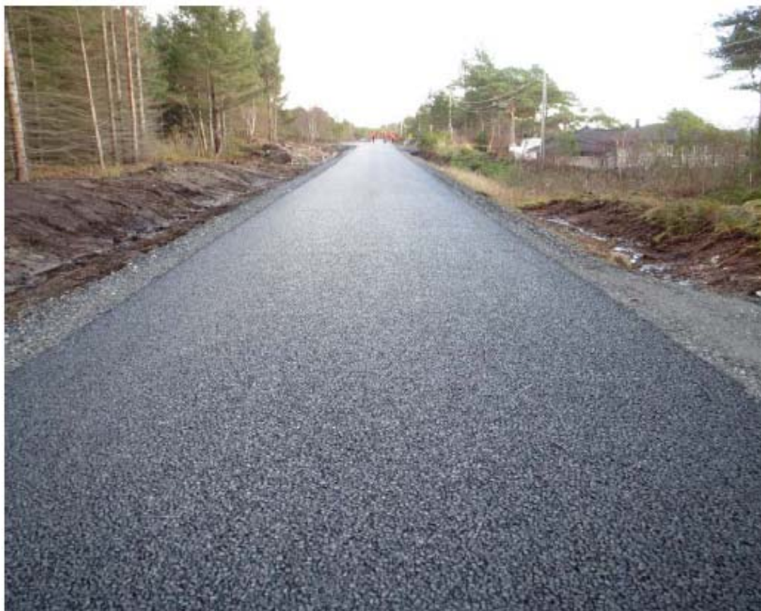
God utførelse, homogent asfaltdekke (foto: Jan Sundstrøm)
