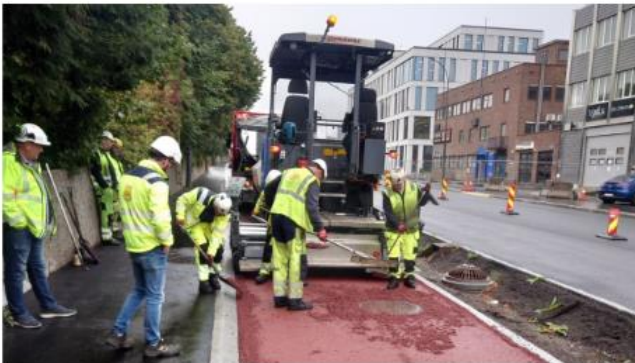
Dynapac SD1800W er bygger sykkelvei i Oslo. Foto: Dynapac
