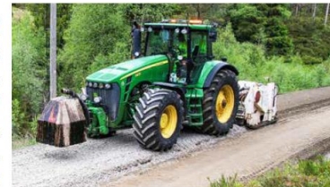
Blandingsfresen i arbeid. Pukkstein er lagt ut oppå den homogene massen fra knusefresen. Det ferdigblandete bærelaget ligger pent igjen der maskinen har kjørt over.
