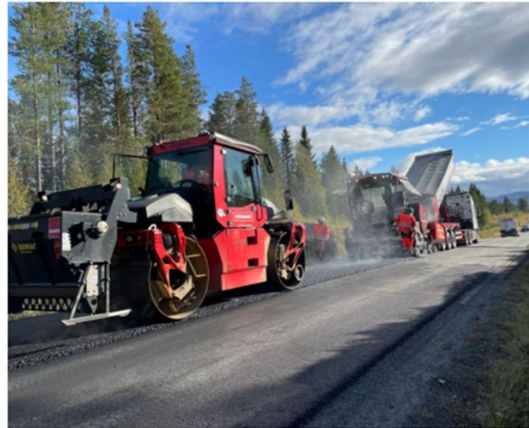
Illustrasjonsbilde. Asfaltering av E14 i Trøndelag. Uttesting av biogent bindemiddel høsten 2021. Foto: Hansen
