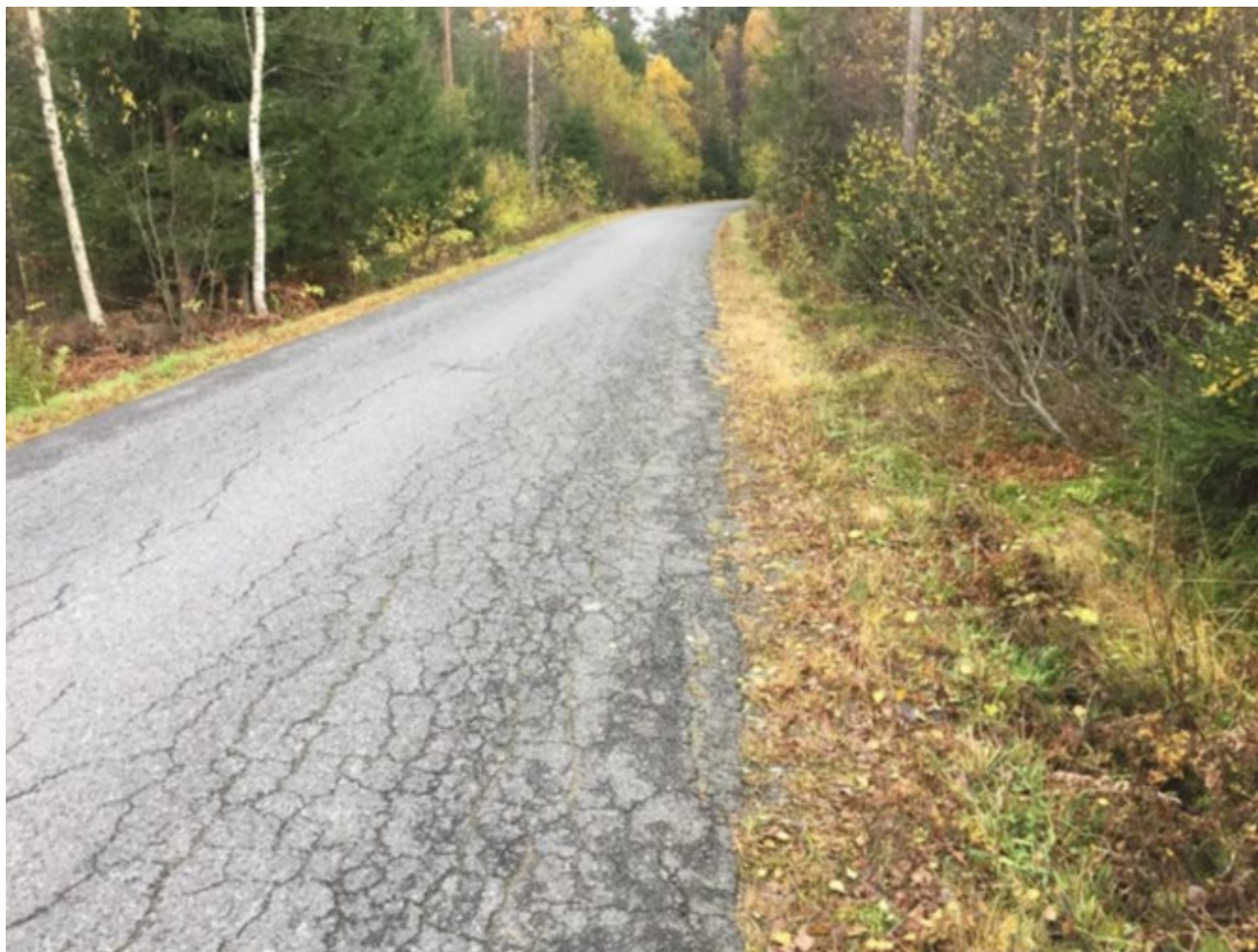
Garderveien før tiltak
