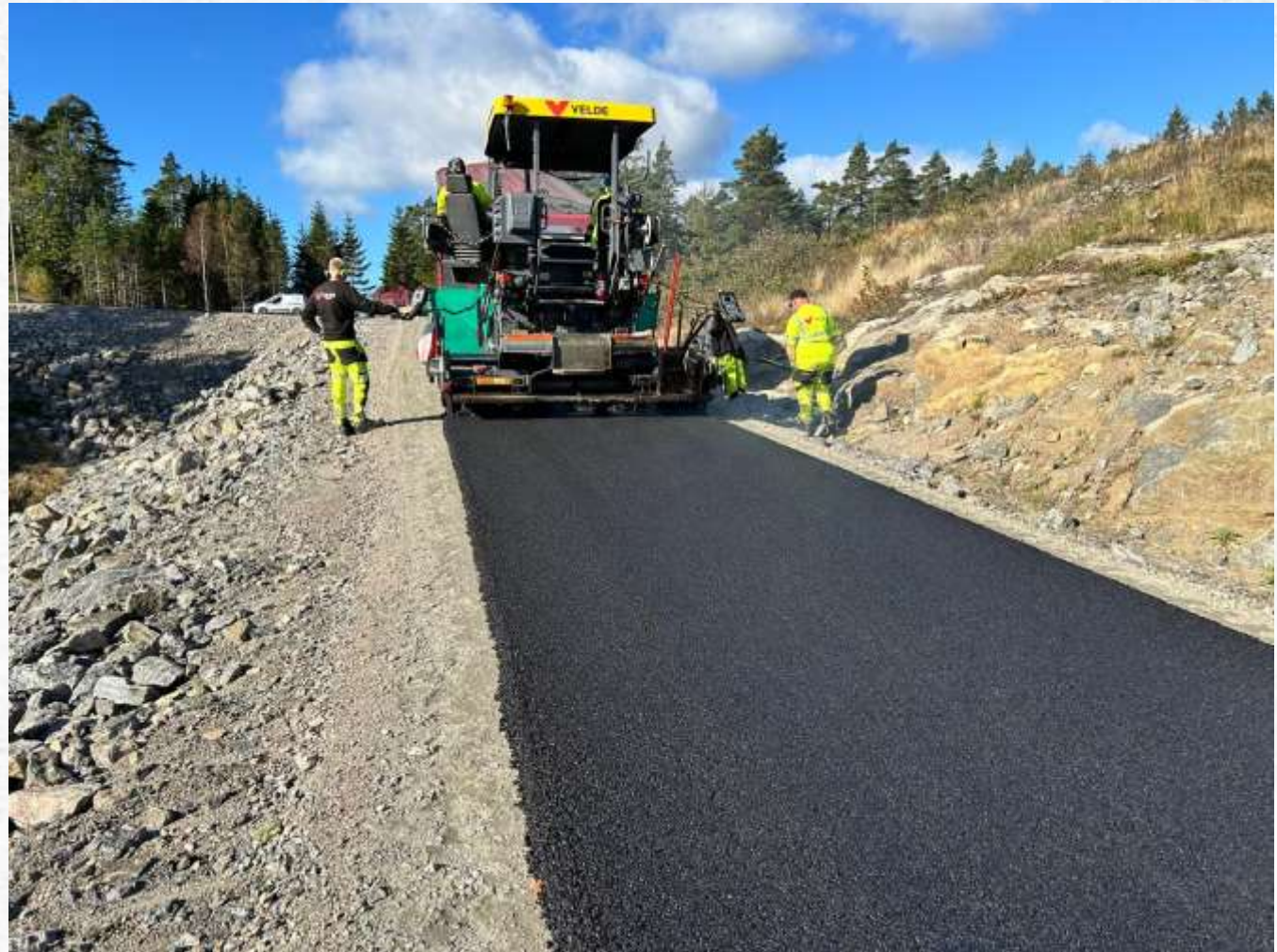
Asfaltering av prøvedekke Agb 16 og Ab 16
