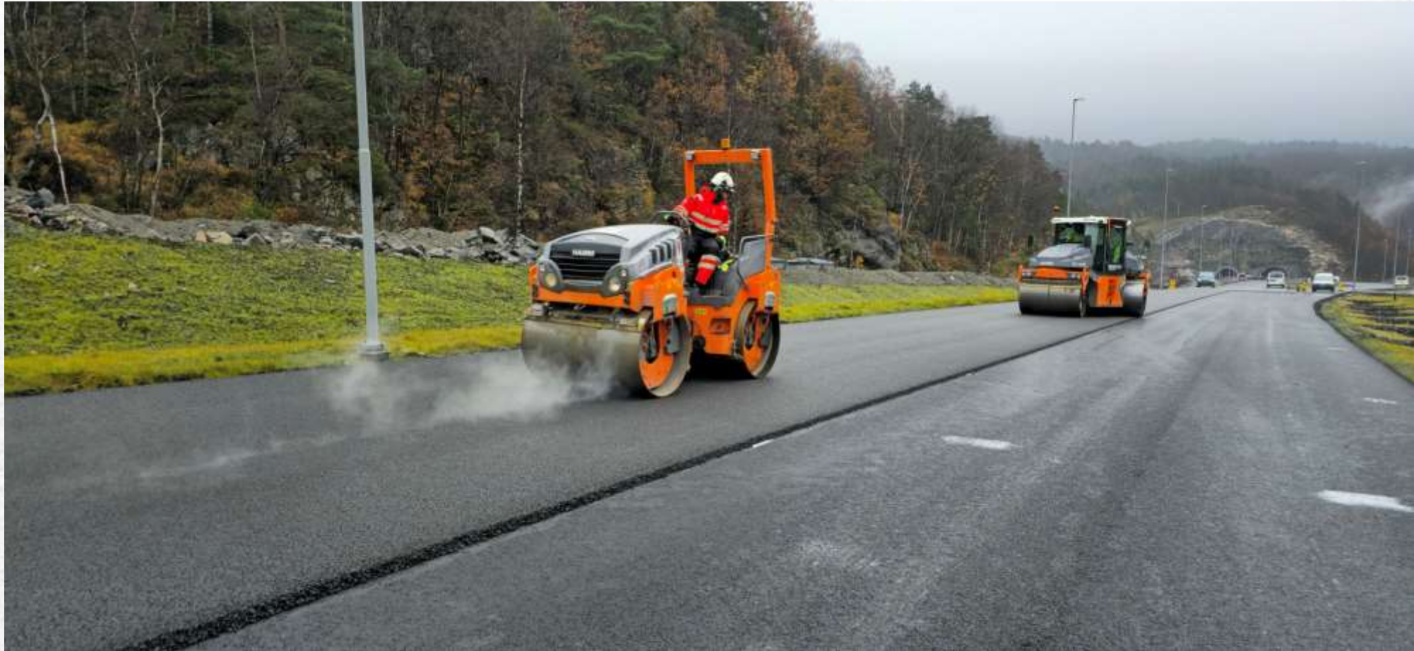
Asfaltering av Ab 16 sirkulært slitelag
