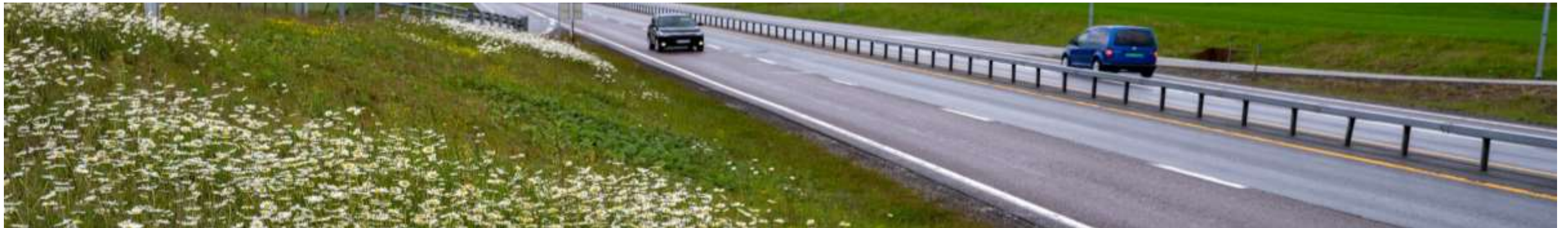
Foto: Bård Asle Nordbø, Statens vegvesen
