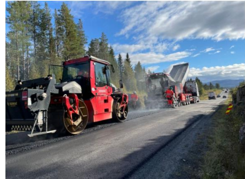
Illustrasjonsbilde. Asfaltering av E14 i Trøndelag. Uttesting av biogent bindemiddel høsten 2021. Foto: Ellinor Hansen
