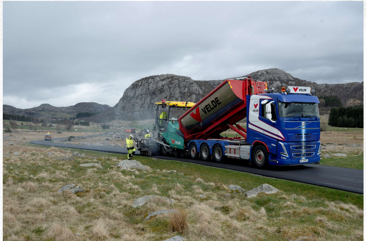
Asfaltering for Sandnes Kommune – Første test på vei Agb 11 Sirkulær
