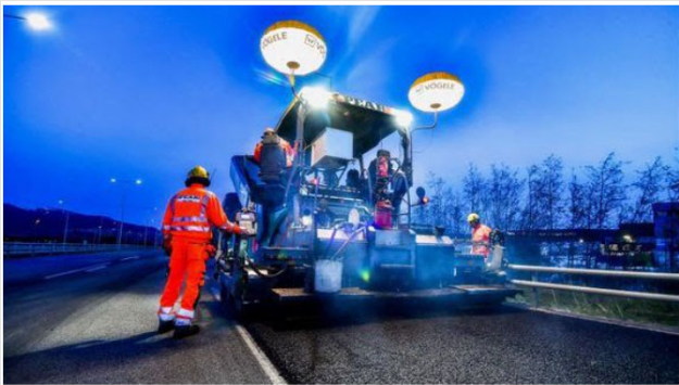
Asfaltkontrakter med egenskapskrav betyr at vegnormalens krav til materialer og sammensetning ikke blir brukt. (Foto: Knut Opseth, Statens vegvesen)
