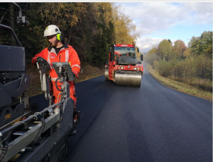
Fra asfaltering med den nye miljøasfalten. Foto: Veidekke
