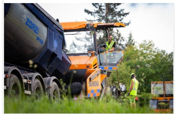
Skanska satser på klimanøytral asfalt. Foto: Skanska
